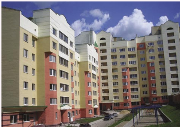
Фото 3. Окончание строительства 10-этажного здания в г. Коломне Московской обл.
