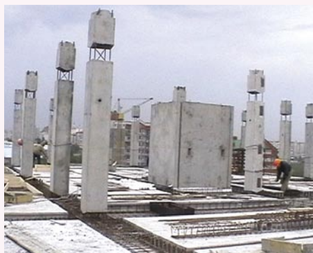
Фото 1. Монтаж диска перекрытия.
