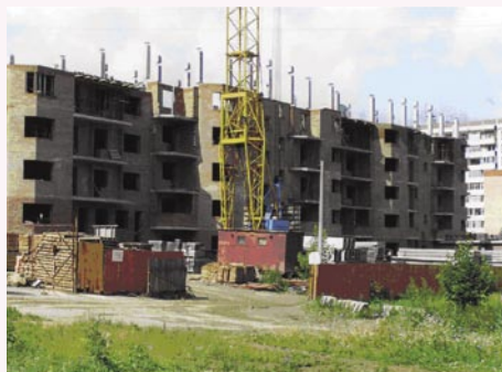
Фото 2. Строительство каркасного сборно-монолитного жилого дома, г. Коломна Московской обл.
