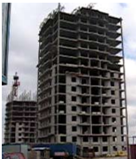
Монтаж каркаса 17-этажного здания в г. Санкт-Петербурге.
