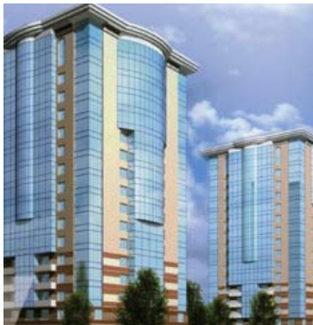
Внешний вид 17-этажного здания со сборно-монолитным каркасом в г. Санкт-Петербурге.
