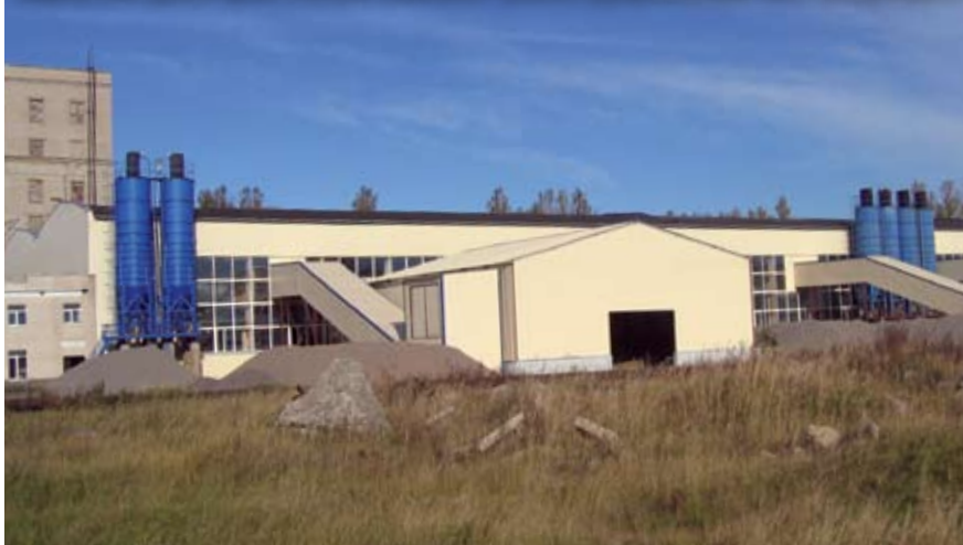
Кировский домостроительный комбинат, реконструированный ЗАО «Вибропресс»
