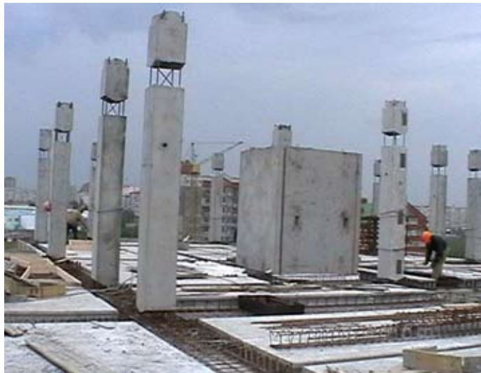
Рис.1 Монтаж сборно-монолитного перекрытия
