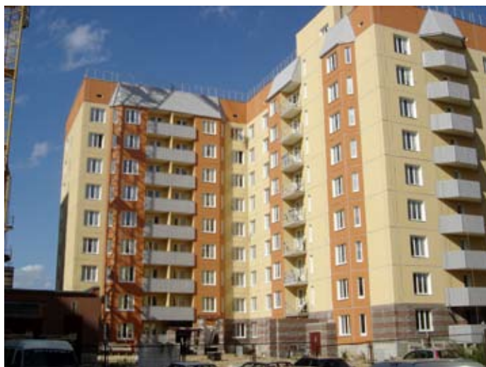
Рис.3 Каркас здания с трехслойными стеновыми панелями
