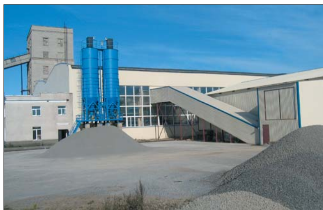
Рис. 6. Бетоносмесительный автоматизированный завод для приготовления бетонной смеси и подачи ее на технологические линии формования изделий и конструкций
