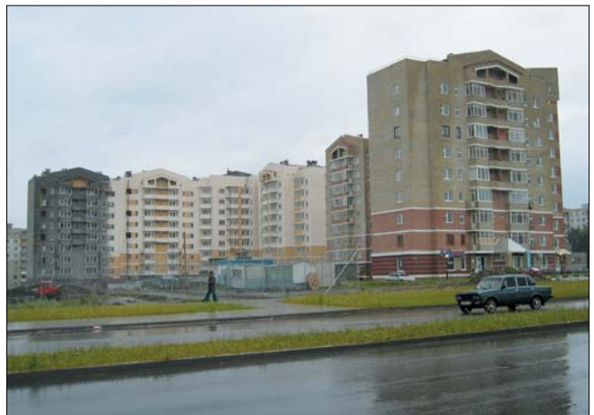
Рис. 2. Жилые 9-этажные здания со сборно-монолитным каркасом, облицованные цветным и серым камнем с последующей покраской
