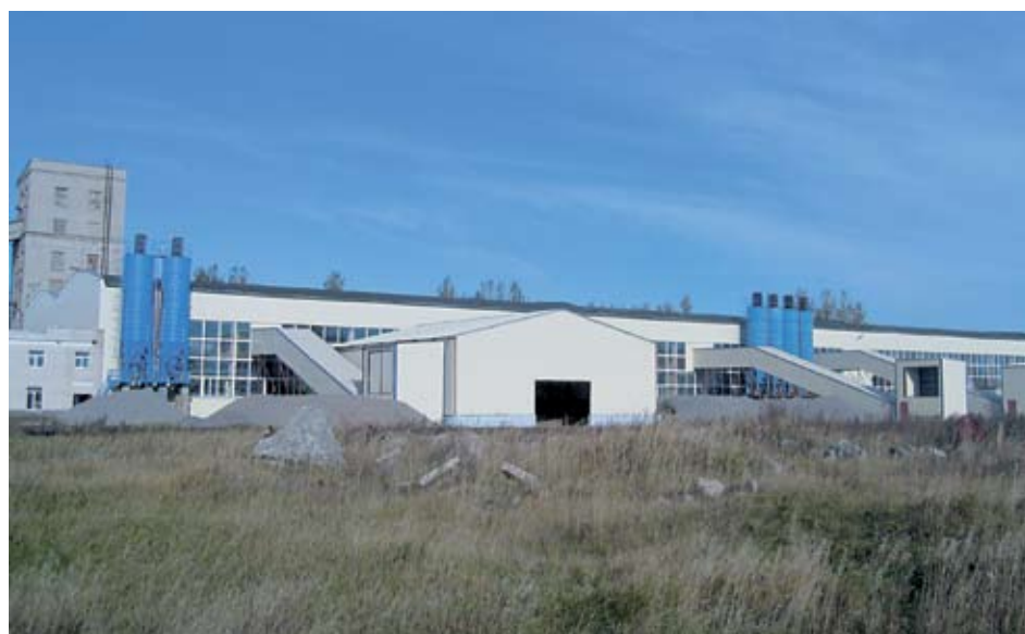
Фото 1. Высокопроизводительный «Кировский ДСК» для строительства каркасных сборно-монолитных зданий. Расположен в г. Кировске Ленинградской обл.
